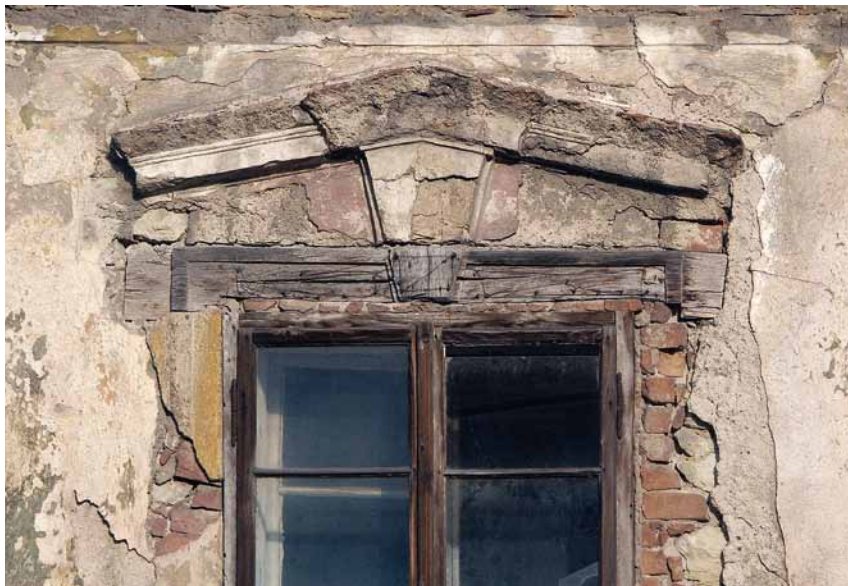
Obr. 22: Snímek připomíná využitelnost této metodiky nejen pro kamenné architektonické prvky. Složitá situace architektonického členění kombinuje dřevo a štuk (Benátky nad Jizerou – okres M. Boleslav, dům čp. 96; foto J. Veselý, 2005).
