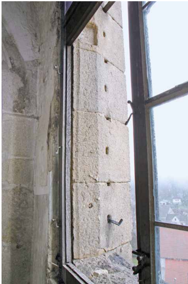
Obr. 13: Architektonické prvky byly často upravovány a nesou stopy mechanického opotřebení. U okenních ostění docházelo k dodatečnému osazování mříží a vnějších oken (Lipnice nad Sázavou – okres Havlíčkův Brod, hrad; foto F. R. Václavík, 2011).
