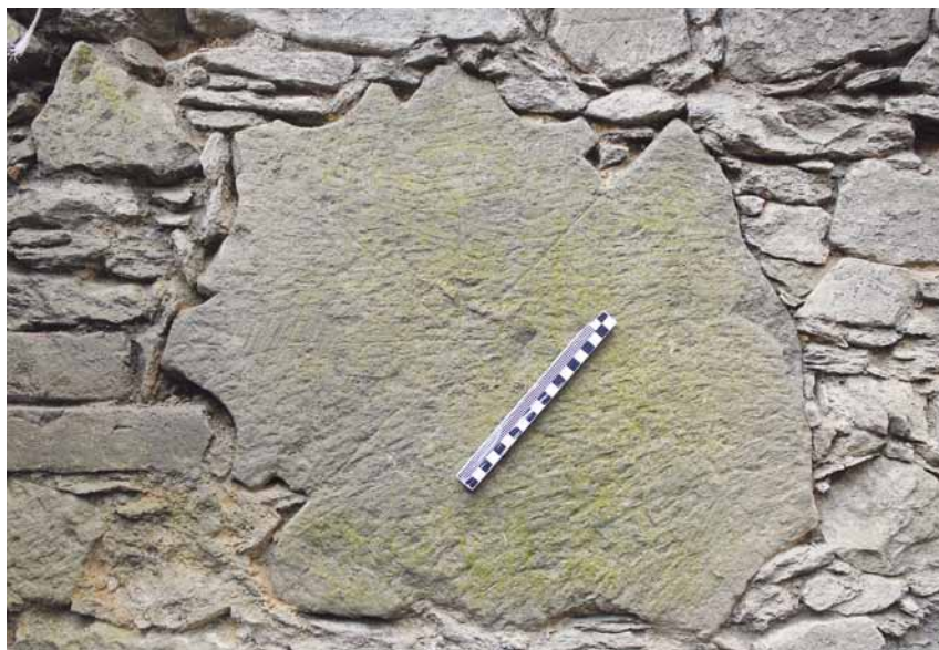
Obr. 10: Na ložné ploše druhotně zazděného prvku jsou dobře patrné osové rysky, které sloužily při rozměřování jeho tvaru (Teplá – okres Cheb, klášterní prelatura; foto M. Panáček, 2014).
