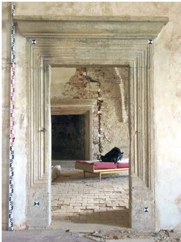
Obr. 8: Hlavní, kolmý snímek dokumentovaného portálu (Lipnice nad Sázavou – okres Havlíčkův Brod, hrad; foto F. R. Václavík, 2011).
